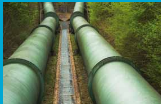
Zwei Druckrohrleitungen verbinden Ober- und Unterbecken.
