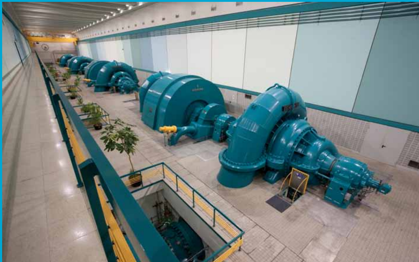
Die vier Maschinensätze im »Krafthaus« werden durch die herabstürzenden Wassermassen angetrieben.
